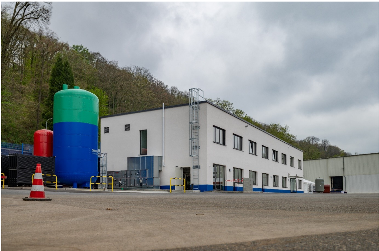
Das Das neue Gebäude mit Eisspeicher, Wärmepufferspeicher und ( im Innern) Gauwasserrecycling mit Wärmerückgewinnung und Hybridheizung.
