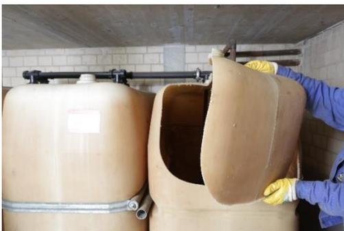
Das Abwracken der alten Tankanlage durch den Fachbetrieb läuft problemlos. Die leer gepumpten Kunststofftanks werden in handliche Einzelteile zerschnitten.
