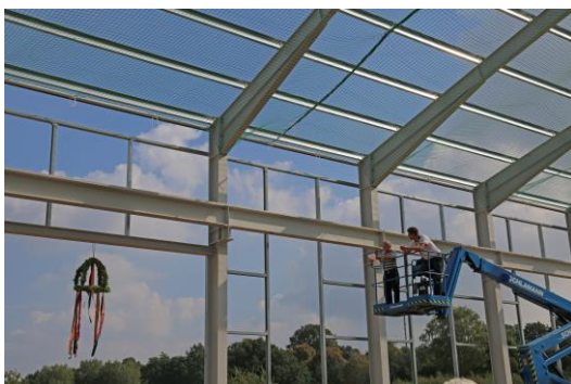
Auch bei modernem Stahlbau gehört der Richtspruch dazu
