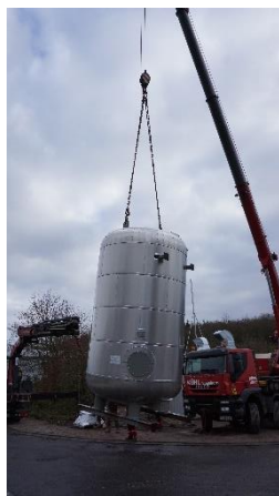
Pufferspeicher der Dehoust GmbH wird angeliefert
