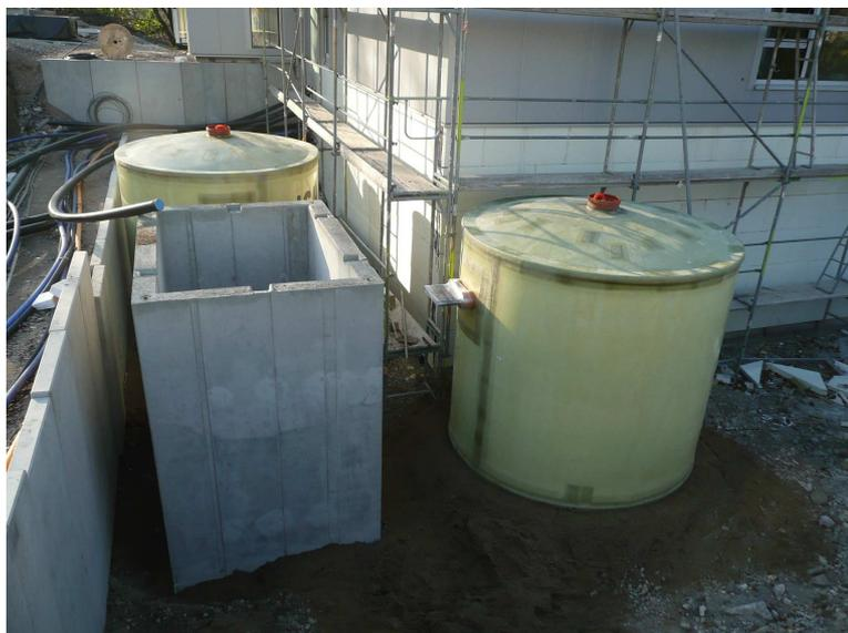
Unterirdische Wärmetanks einfach und platz sparend installiert.
