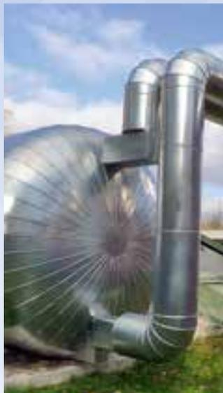
Heizungspufferspeicher für die Außenaufstellung
