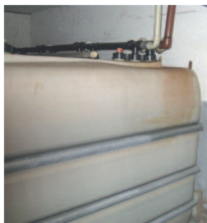
▲ Bild 2 • Einwandige Öltanks gehören der Vergangenheit an.
