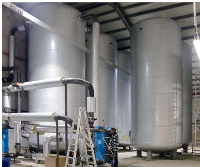
Die Wärmetanks sind im Gebäude aufgestellt und werden in das Nah- und Fernwärmenetz eingebunden.
