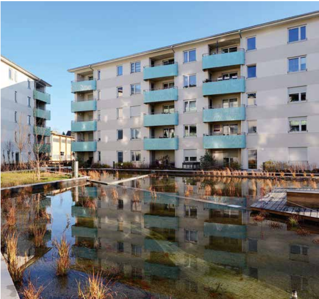
Im neuen Wohnquartier in Mannheim Aubuckel sorgen eine Grauwasseraufbereitungsanlage der Firma Dehoust und ein Teich, der Regenwasser sammelt, für effizientes Wassermanagement. Die GWtec 340-Anlage von Dehoust läuft mit einer Aufbereitungsleistung von 15.000 l/d.
