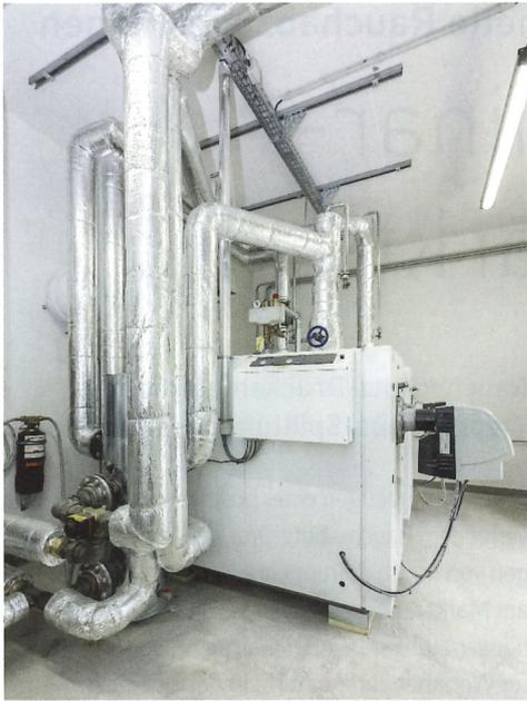
**Bild 8 • Alle hydraulischen Anschlüsse sind beim Straton XL platzsparend oben am Kessel angebracht und das Flammrohr sowie der zweite und dritte Abgaszug übereinander angeordnet.**
