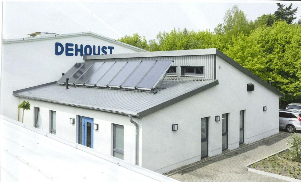
**Bild 2 • Auf dem neuen Sozialgebäude ist eine Solarton Solarthermie-Anlage von Elco mit insgesamt acht Flachkollektoren installiert. Heizungs- und Warmwasser des Neubaus werden hauptsächlich darüber erwärmt.**
