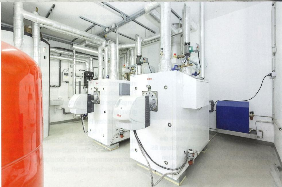
**Bild 7 • Da die Produktionshalle ebenfalls über die neue Heizungsanlage versorgt werden soll, wurden in der Lackierhalle gleich zwei Straton XL 150 Öl-Brennwertkessel von Elco eingeplant. Sie ergänzen die Luft-Wasser-Wärmepumpe.**
