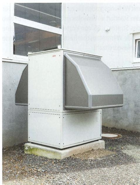
**Bild 6 • Für die neue Lackier- und die bestehende Produktionshalle liefert die Luft-Wasser-Wärmepumpe Aerotop T35H von Elco regenerative Energie, um die Anforderungen der EnEV zu erfüllen.**
