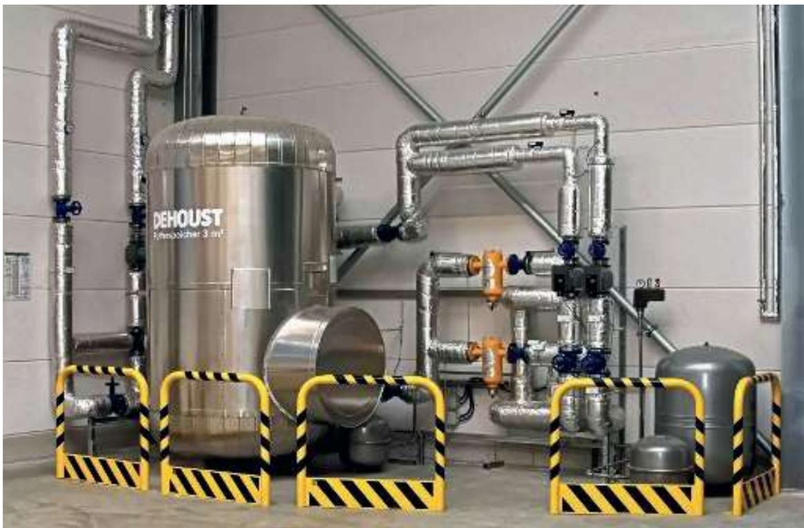
Ein schneller Einbau vor Ort ist durch die werkseitige Dämmung besonders unkompliziert.
