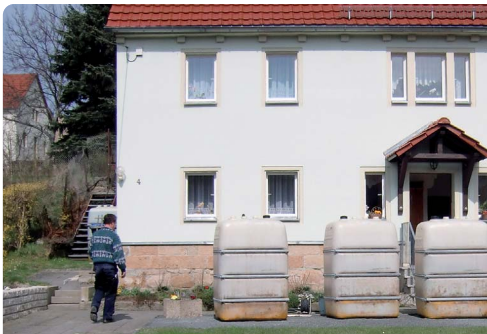
Ausrangiert: Die alten Tanks nimmt der Installateur zur Entsorgung mit.
