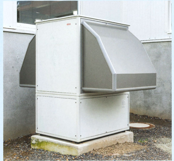
Für die neue Lackierhalle sowie für die Produktionshalle liefert eine Luft-Wasser-Wärmepumpe regenerative Energie, um die Anforderungen der EnEV zu erfüllen.
