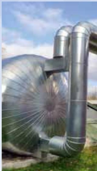
Heizungspufferspeicher für die Außenaufstellung
