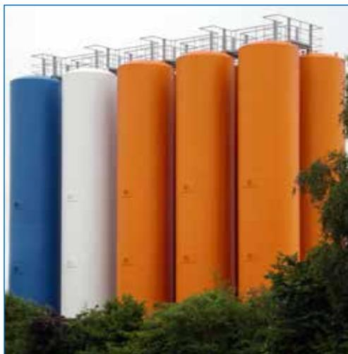
Oberirdische, stehende ein- und doppelwandige Behälter mit abZ bieten die Möglichkeit, große Lagervolumen platzsparend auf geringer Grundfläche in Gebäuden oder im Freien aufzustellen. Wind- und Erdbebenlasten werden entsprechend berücksichtigt.
