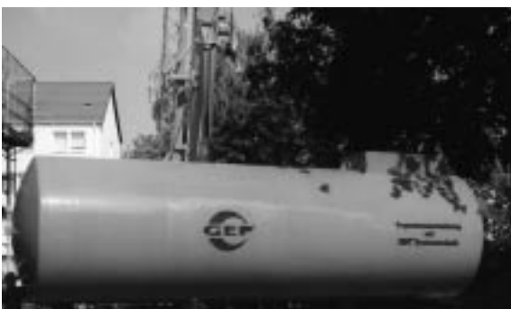
Kunststoff ummantelte Zisterne mit Stahlkern
