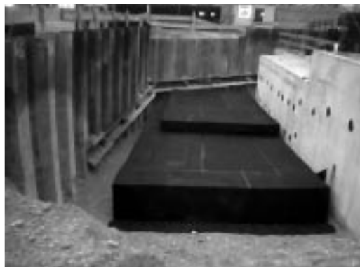
Kunststoff Volumenkörperspeicher, Bauhöhe min. 45 cm
