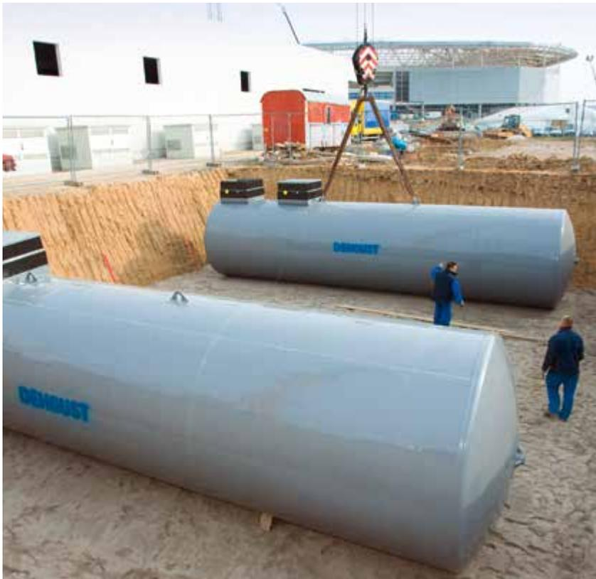
Lagerbehälter zur Sammlung von Regenwasser können bei Bedarf gleichzeitig auch als Löschwasser-Vorratsbehälter genutzt werden – doppelter Nutzen in Kombination mit mehr Sicherheit.
