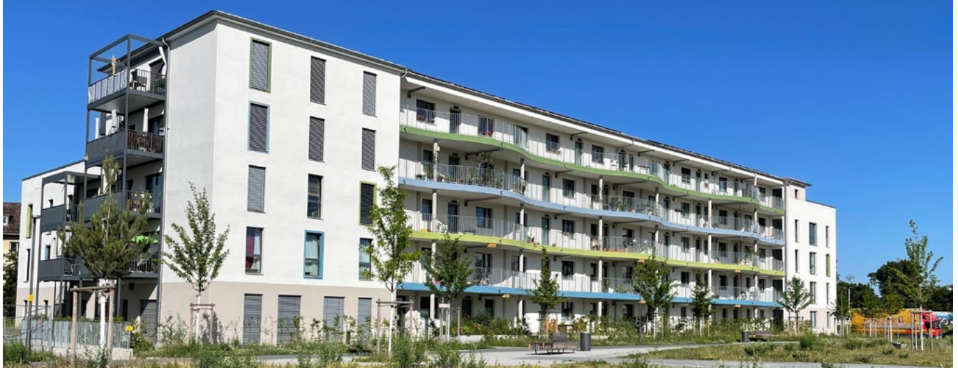
Eine DEHOUST GWtec® Anlage nutzt das Abwasser aus Dusche und Bad der über 50 Wohnungen im Gebäude der WohnSinn e.G. in der Lincoln Siedlung in Darmstadt.
