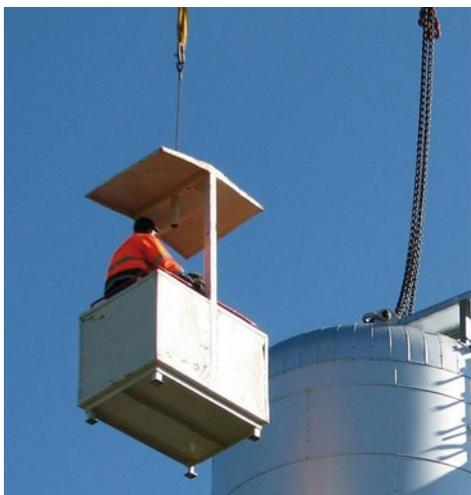
Ketten des Kranes aus den Tragösen Aushängen. Montage der beigeestellten Isolierhauben für Tragösen und Mannloch.
