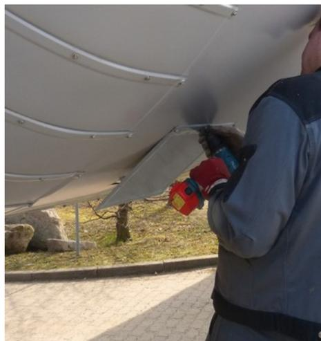
Entfernen der Transportfüße am zylindrischen Behälterteil und Nachisolieren der Aussparungen mit beigestelltem Isoliermaterial (Mineralwolle, Bohrer, Schrauben, Abdeckblech mit Dichtband).
