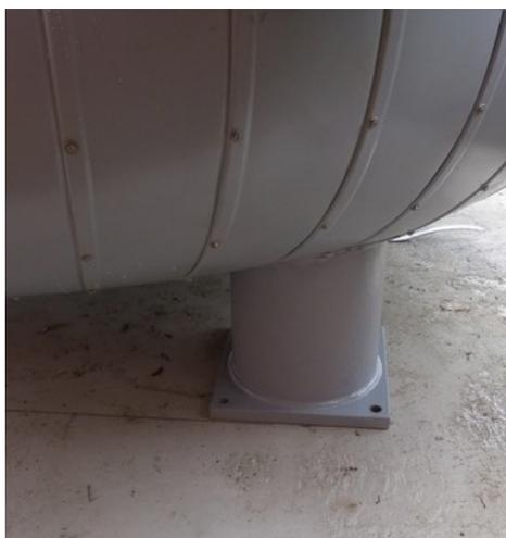
Aufsetzen des Speichers auf das Fundament und anzeichnen der Bohrlöcher.
