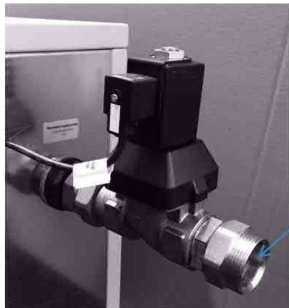
Abbildung 40: hydraulischer Anschluss des Regenwasserstops
