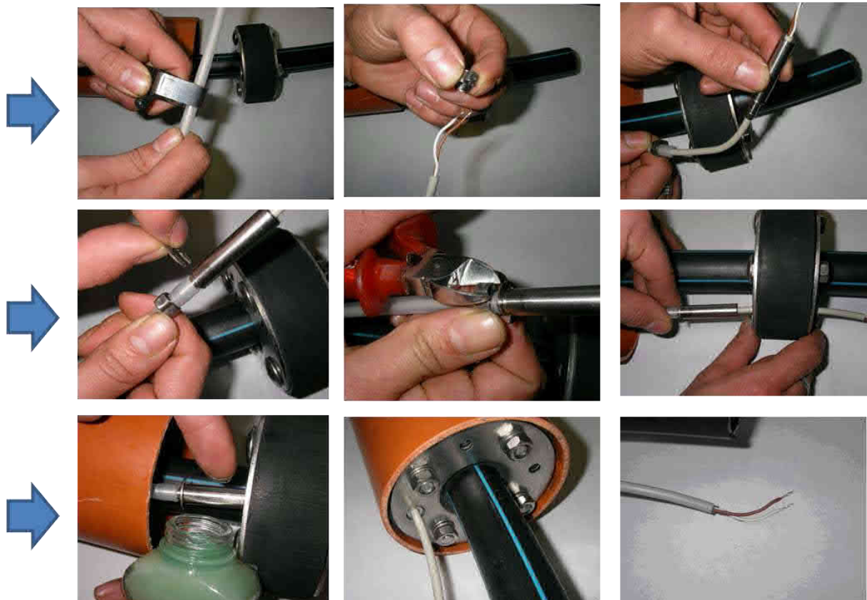
Abbildung 44: Installation des Anschlusskabels mit dem Edelstahlrohr
