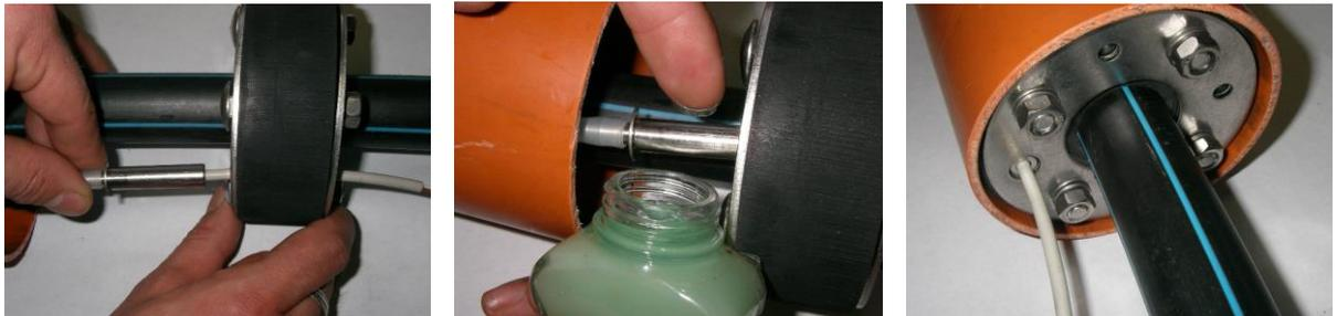
Das Kabel wird durch die hierfür vorgesehene Öffnung des Dichtungselementes geschoben. Das Edelstahlrohr sollte mit geeignetem Gleitmittel versehene werden und in die Durchführung geschoben werden. Wenn das Edelstahlrohr bis zum Anschlag eingeführt wurde, kann das Dichtungselement nach der zugehörigen Installationsanleitung eingebaut werden.
