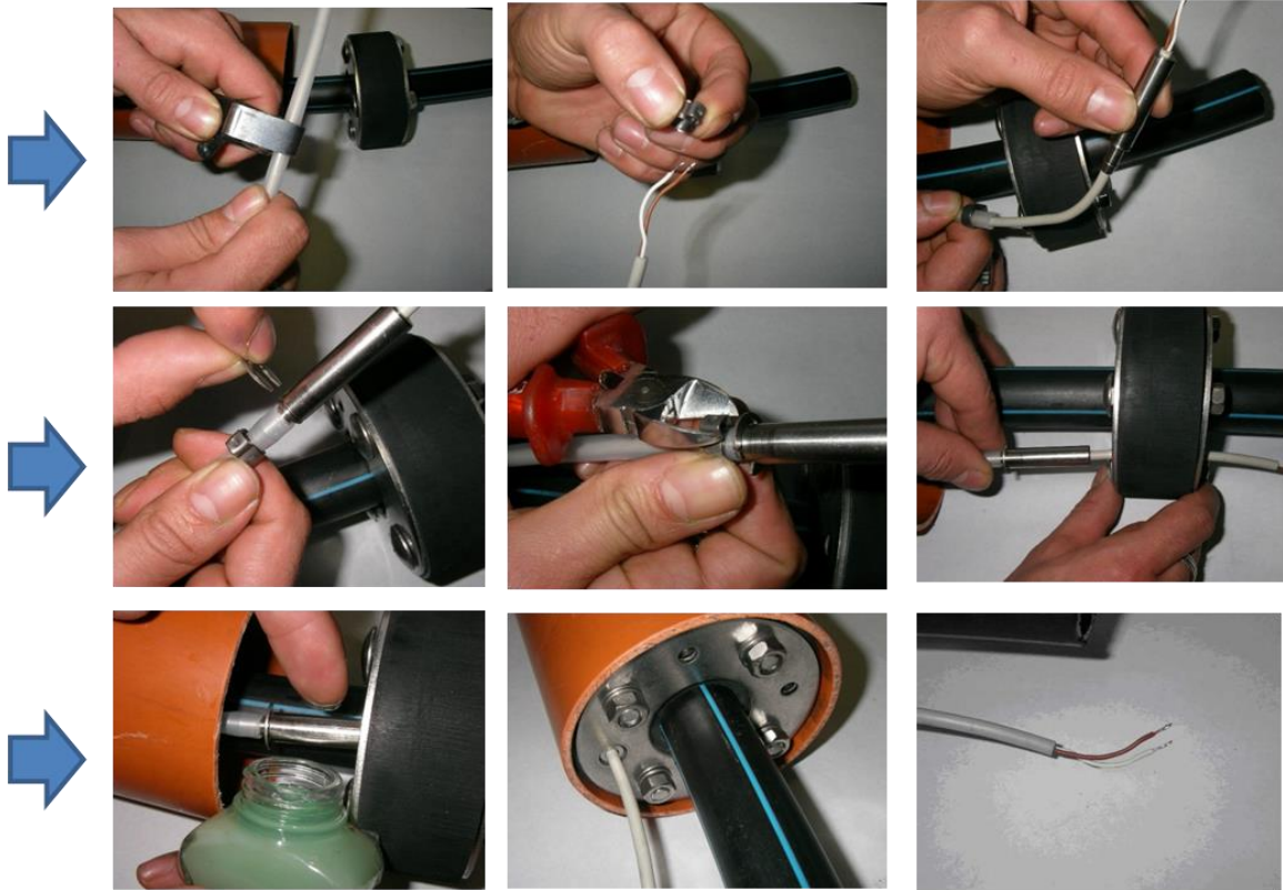
Abbildung 8: Installation des Anschlusskabels mit Schutzschlauch in Dichtungssatz der Hauseinführung
