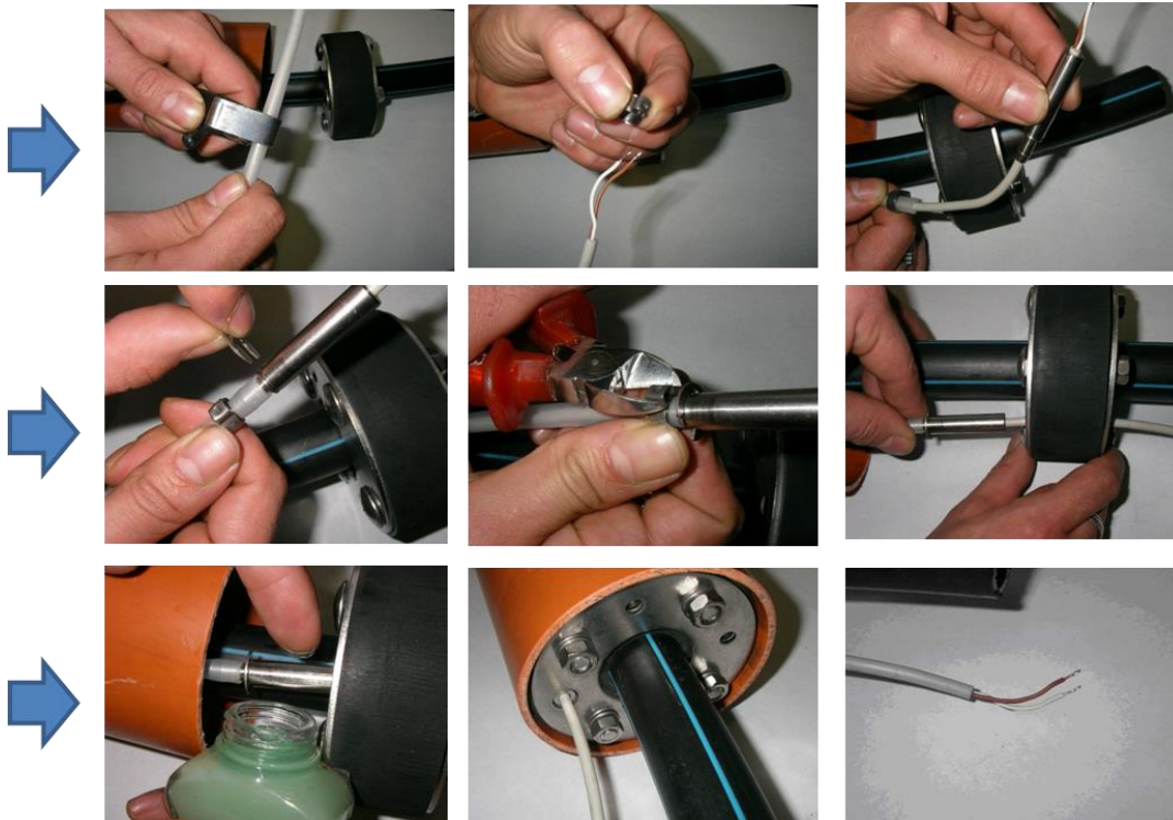
Abbildung 56: Installation des Anschlusskabels mit Schutzschlauch in Dichtungssatz der Hauseinführung
