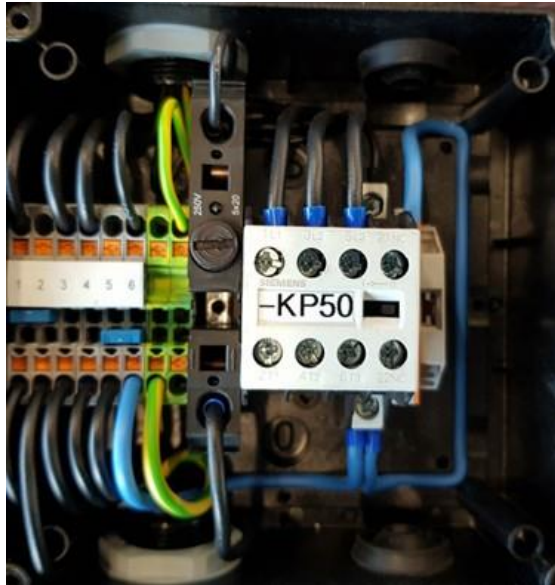
Abbildung 15: Anschlussbox Zubringer TOP
