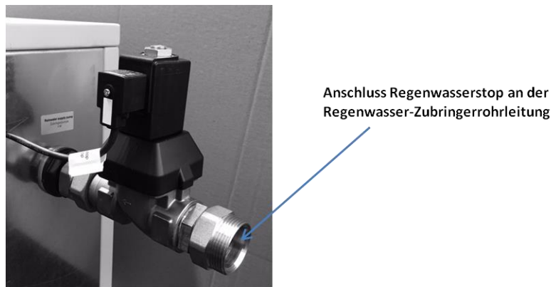
Abbildung 53: hydraulischer Anschluss des Regenwasserstops
