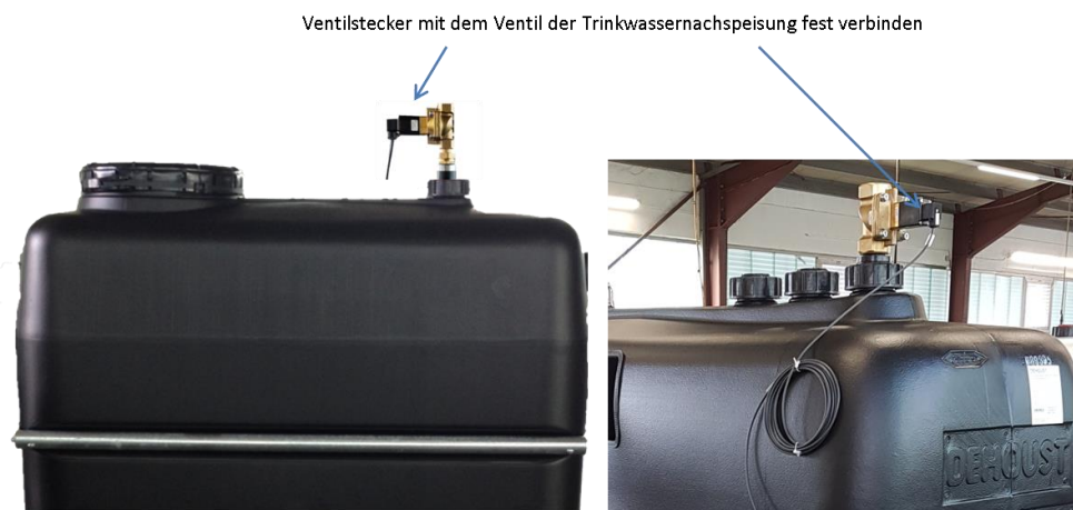
Abbildung 11: Anschluss des Ventils zur Trinkwassernachspeisung
