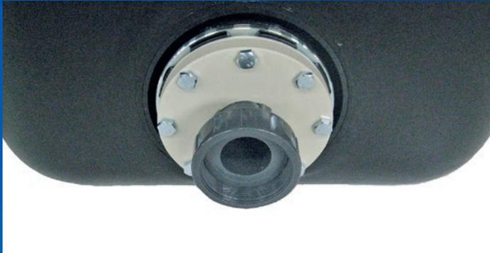
6. PVC-Kupplung 2" in den PP Flansch mit Dichtband einschrauben, ausrichten und den Gewindeinsatz abschrauben.
